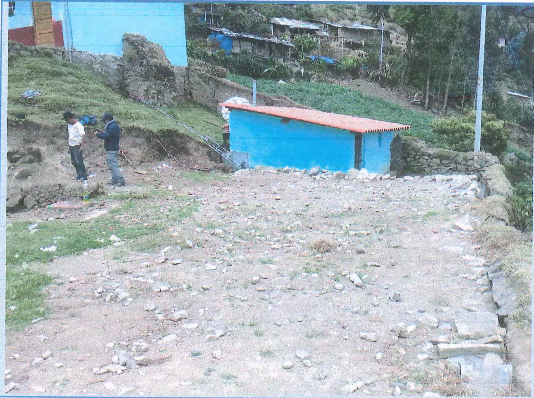
Foto 6: Vista exterior del Módulo Cocina
