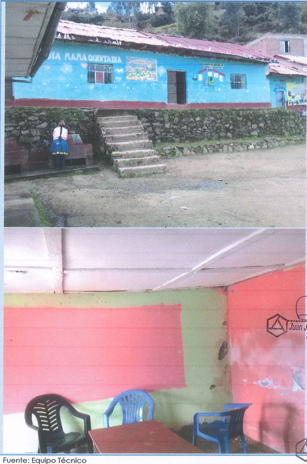
Foto 1-2: Vista Modulo aulas sección 5 y 6to grado
