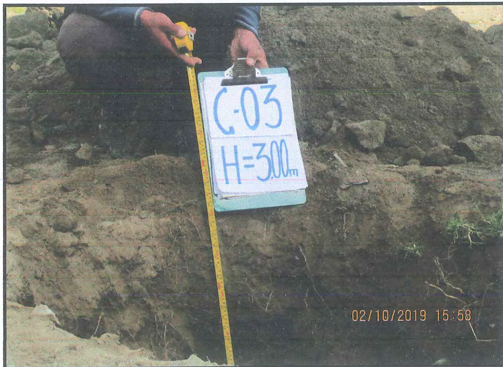
Vista N° 7. Excavación de calicata 03 altura 3.00 ml.
